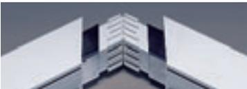
und die Profilverstärkungen aus Stahl sowie die zweifache Eckverbindung garantieren hohe Stabilität und Funktionssicherheit Ihrer Tür. Jede
