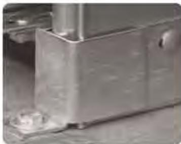
Eine mit dem Boden fest verschraubte Stahl-Konstruktion macht ein „Aushebeln“ von außen unmöglich.
